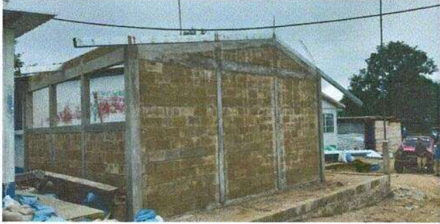
Foto1: Sustitución de lámina, por lámina troquelada aluzinc calibre 26 en aula
