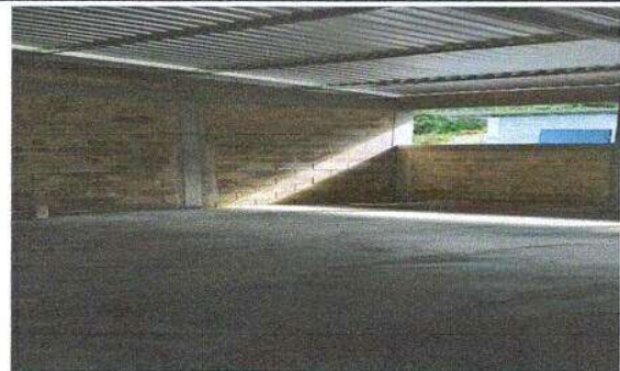
Foto 4: Sustitución de piso de torta de concreto en aula.
