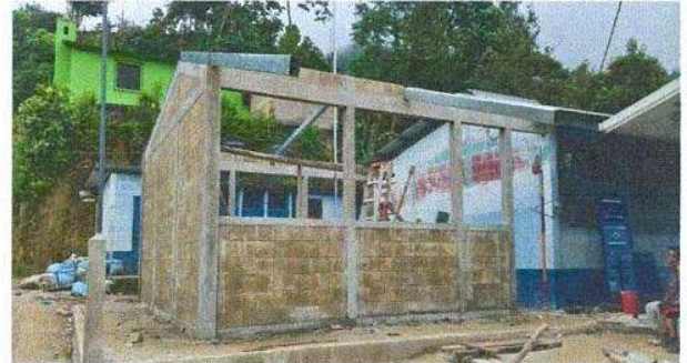
Foto 2: Sustitución de estructura de soporte de madera, por metal en aula.
