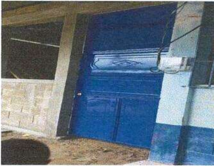
Foto 3: Sustitución de puerta de madera por puerta de metal en aula
