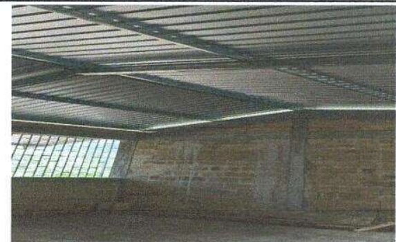
Foto 6: Interior de aulas
